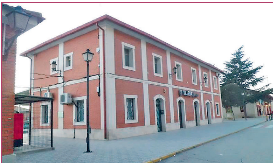
Estación de Villena
