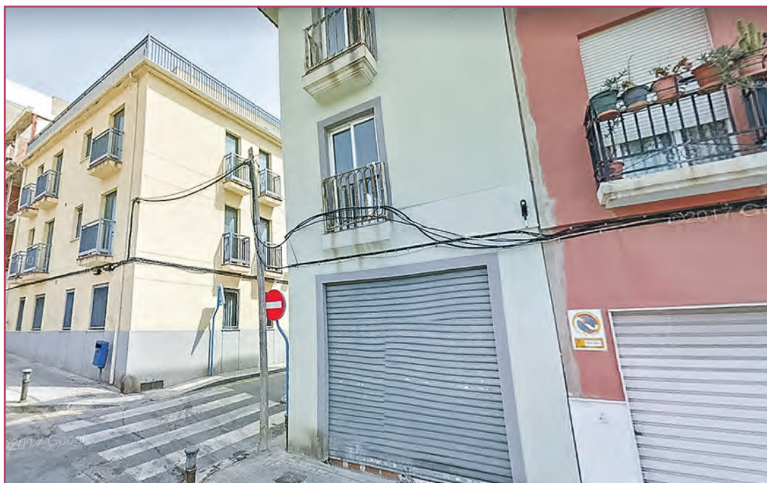
Los cables eléctricos sobre las fachadas o cruzando las calles dan cierta imagen tercermundista al barrio.
