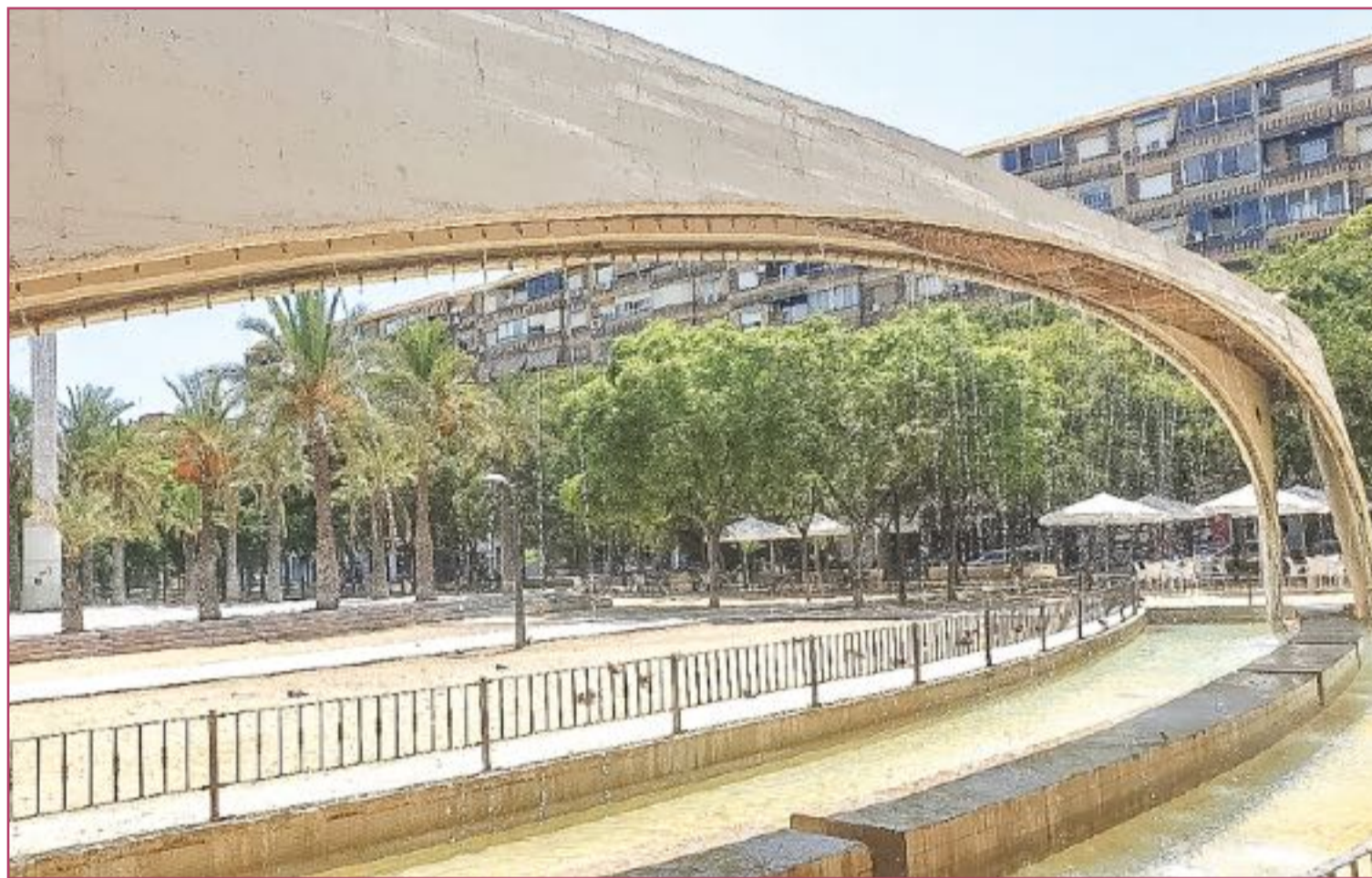
La fuente del parque sufre ya algunos deterioros que serán reparados.
