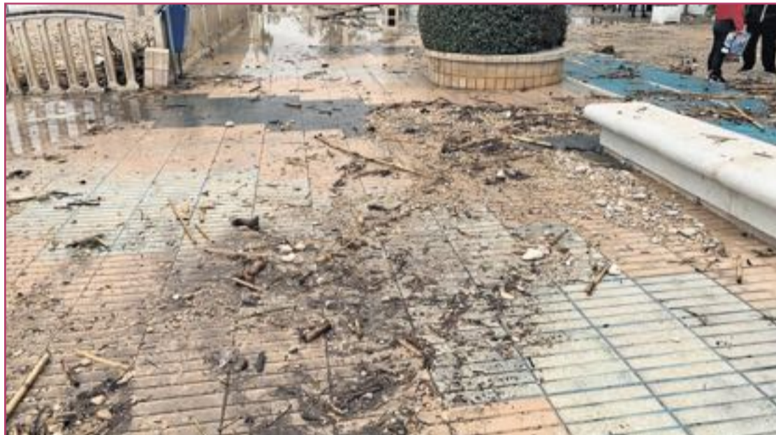
Los daños en las infraestructuras tardarán un tiempo en subsanarse.
