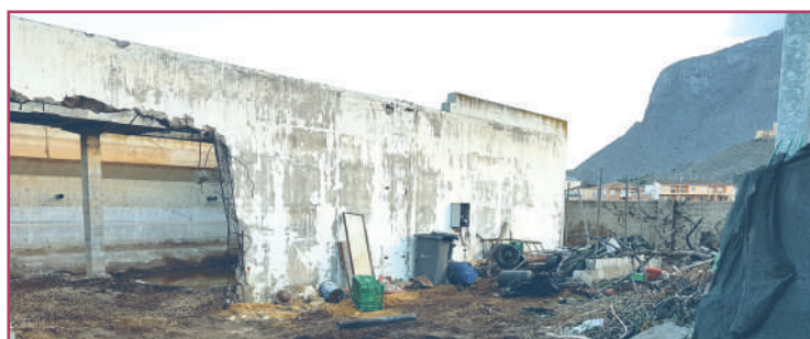
Obras en la depuradora
