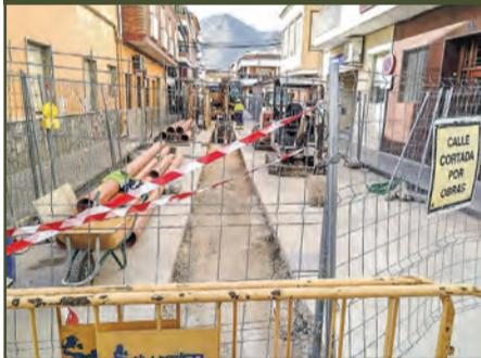
Una rotura del alcantarillado en la calle Antonio Machado ha hecho necesario que el ayuntamiento aborde su reparación para evitar posibles filtraciones a los vecinos. La obra, que se ha tenido que hacer por la vía de urgencia, la está realizando Hidraqua y consiste en la renovación de la tubería de saneamiento, arquetas, imbornales, etc. en un espacio lineal de 50 m, con un coste de 30.000 euros.
