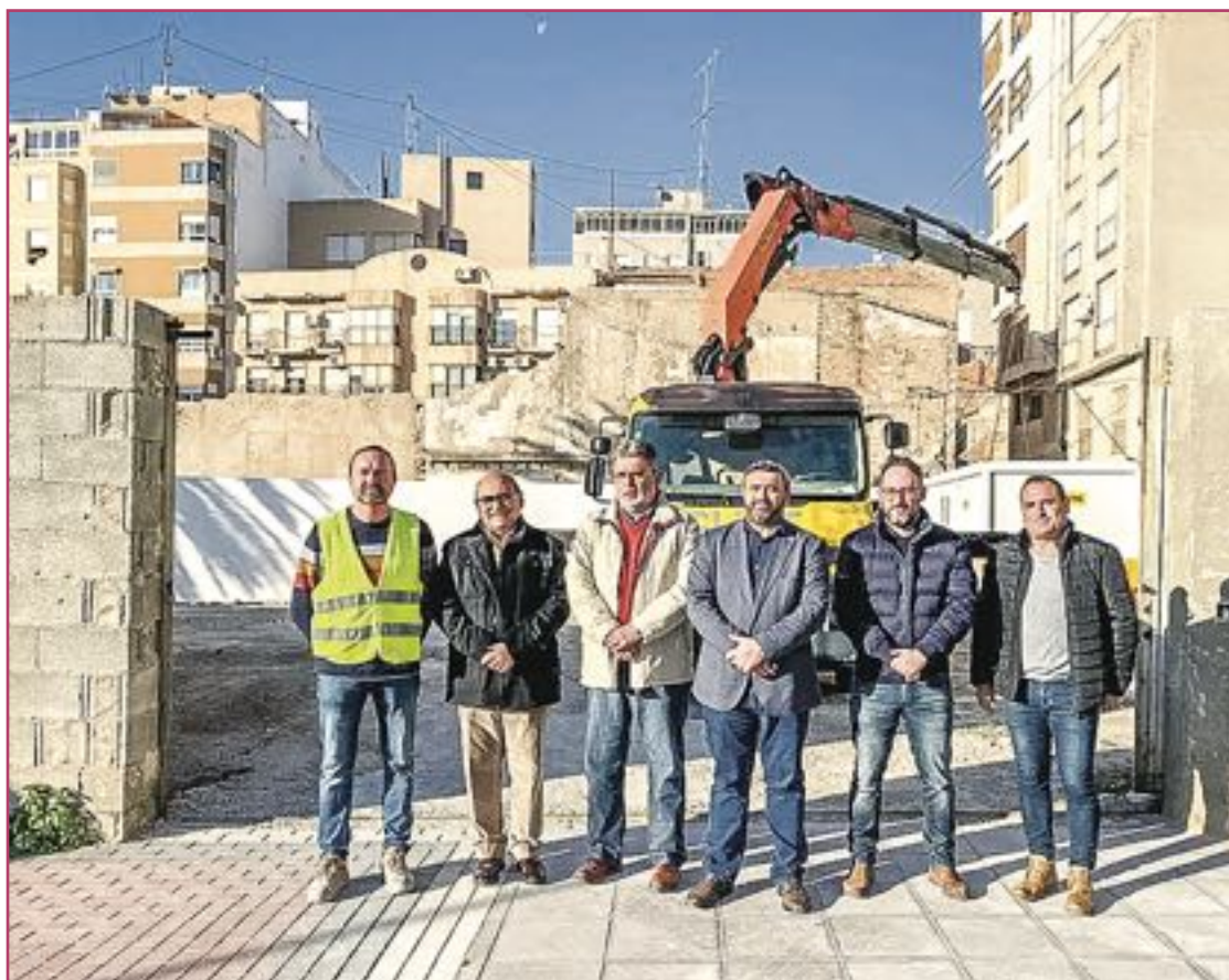
El alcalde José Manuel Penalva y varios concejales supervisan las obras.
