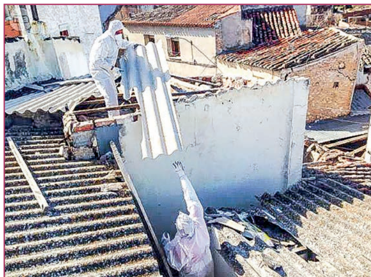
Operarios retiran amianto de una casa de Alicante
