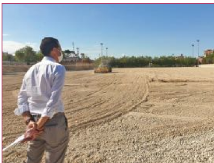
Así marchan las obras de remodelación en el campo de La Sismat.
