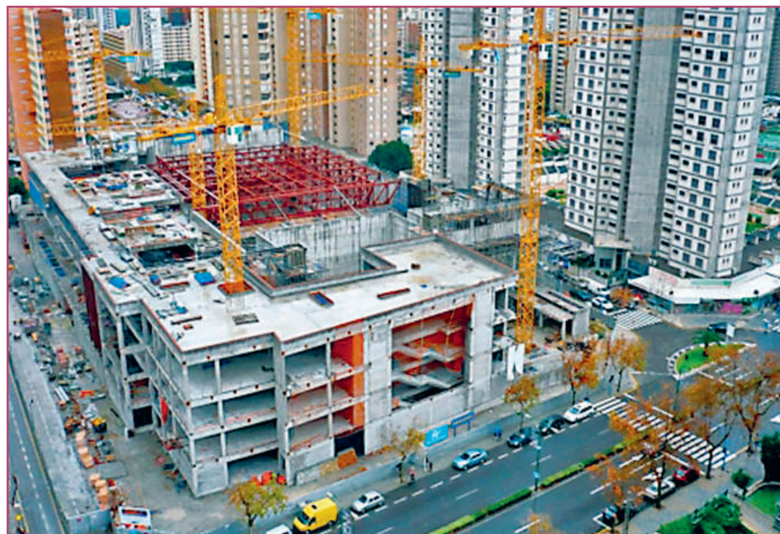
Estado actual del Centro Cultural de Benidorm.
