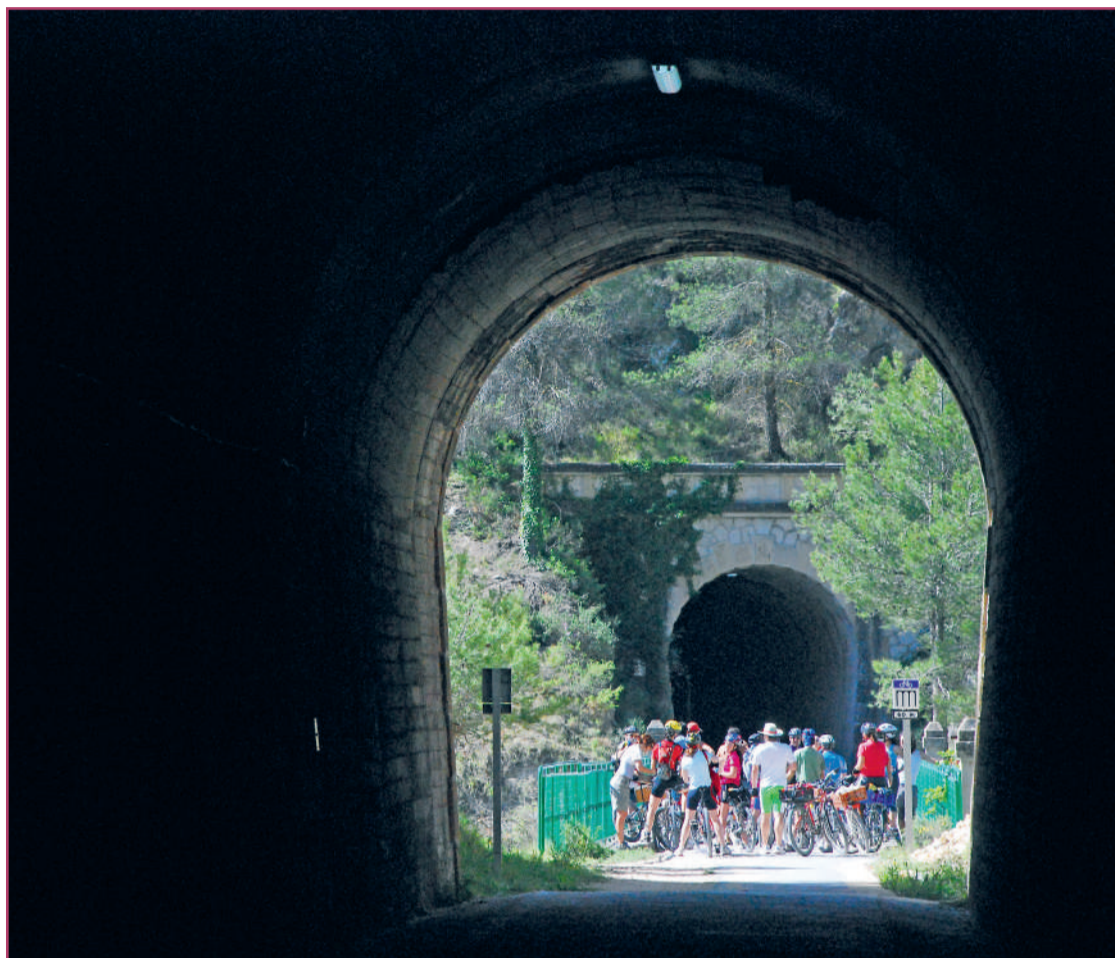
Se hace necesario llevar linternas para los tramos de túnel | ©FFE_Vías Verdes. viasverdes.com
