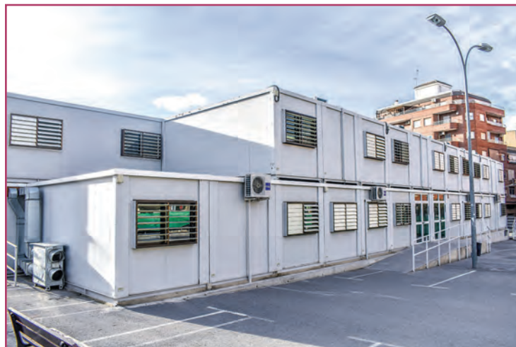
Los alumnos están dando clase en aulas prefabricadas.
