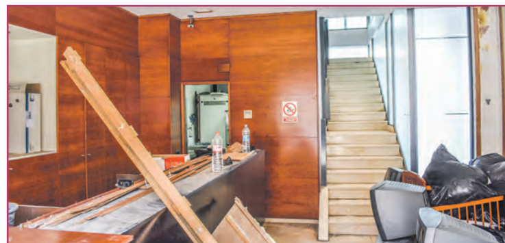
La recepción del hotel, tras su reforma, será más espaciosa.
