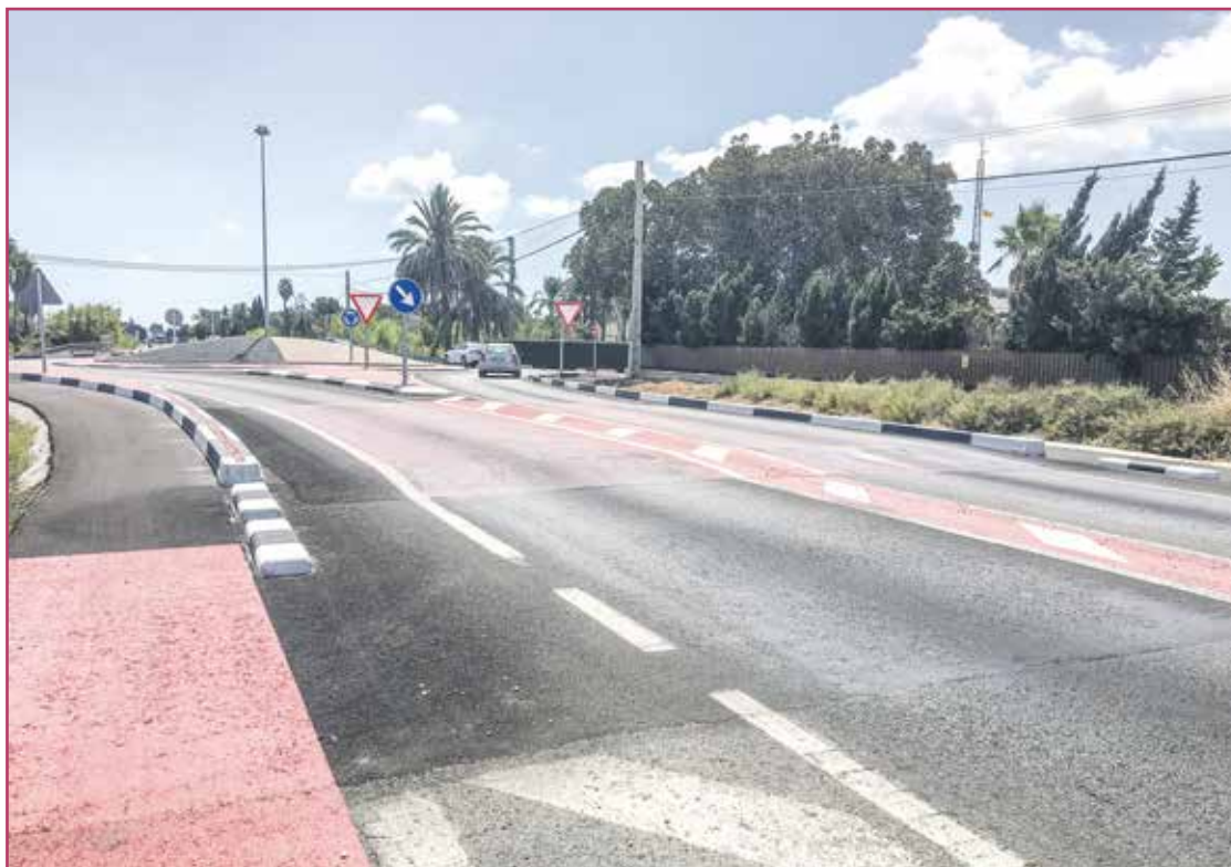
Aparte de las rotondas se ha incluido un paso súper elevado sin ninguna finalidad concreta.
