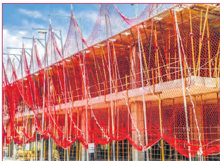
En la actualidad todas las obras en construcción deben cubrirse con redes, un gran producto para el sector.
