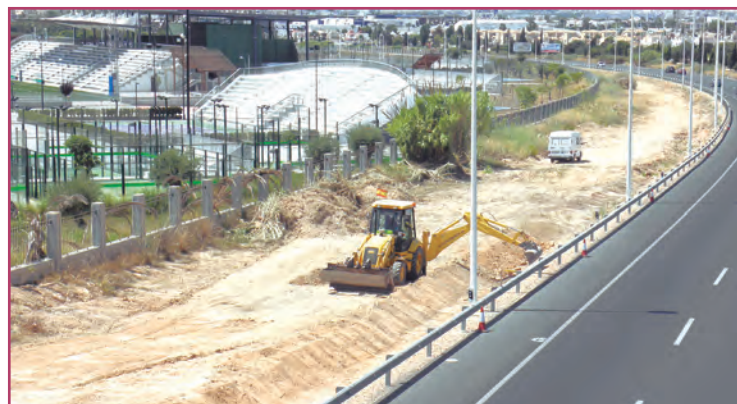
Obras de 2015. Cajón de pluviales paralelo a la CV-905.
