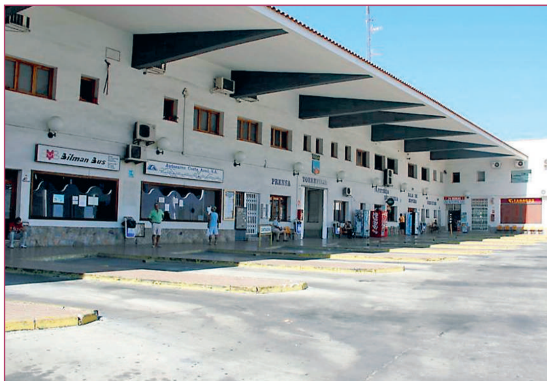
Estación de autobuses de Torreveja
