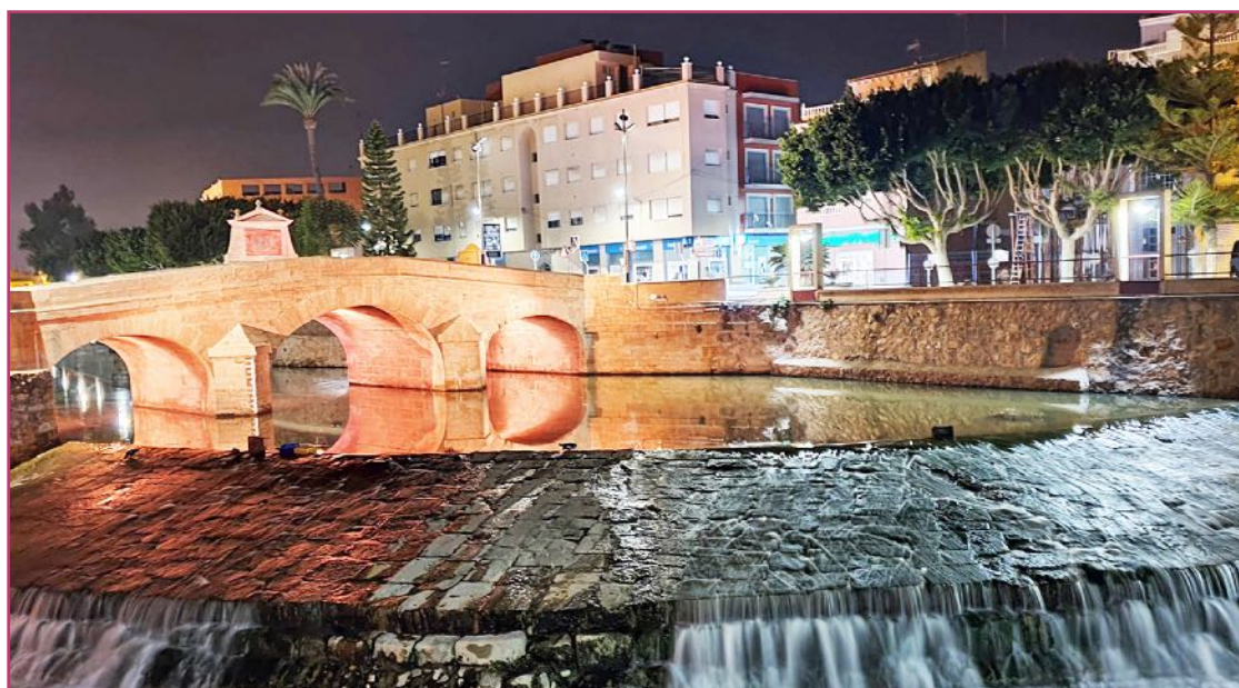
Nueva iluminación en el Puente de Sillería.
