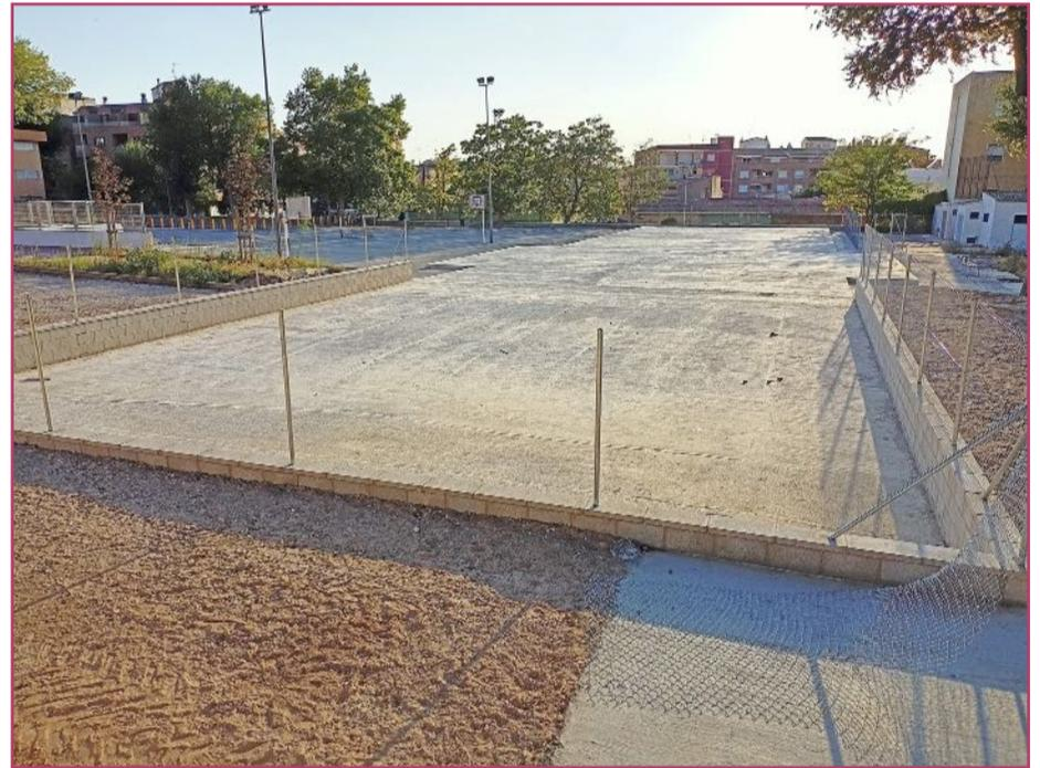
Solera preparada para aulas prefabricadas.
