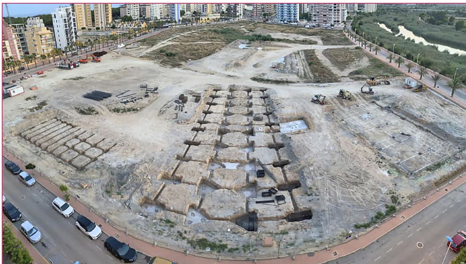
Obras en la parcela del nuevo CEIP Dama de Guardamar.
