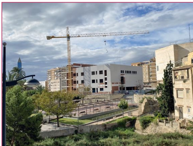
Estado actual de las obras del Teatro Chapí.
