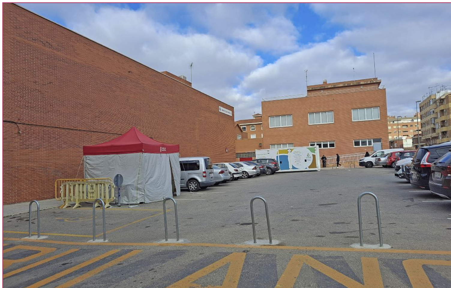
Parte trasera del centro de salud, donde se va a realizar la ampliación.
