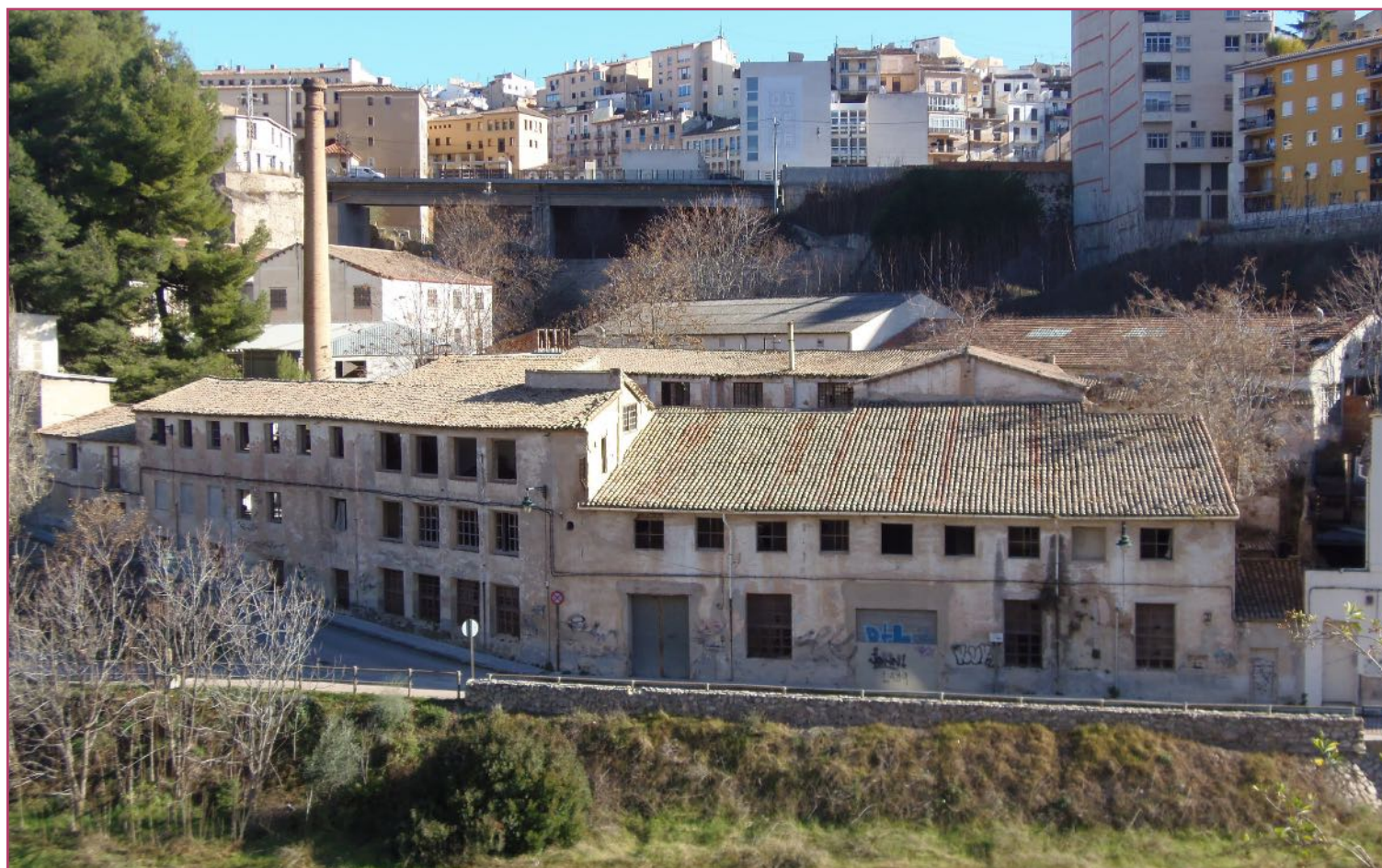
Abandonado espacio fabril en el cauce del río Riquer.
