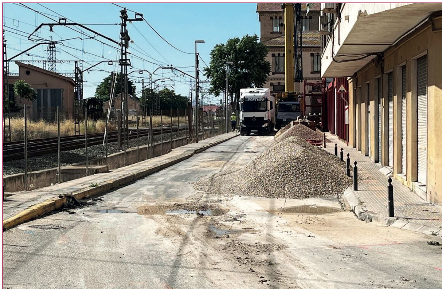
Las obras para el trazado de la nueva red de saneamiento han comenzado al inicio de Rosalía de Castro.
