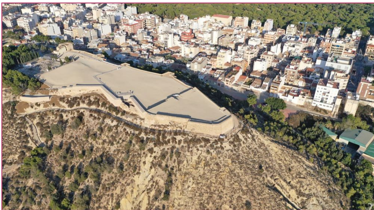
Vista aérea del Castillo de Guardamar.
