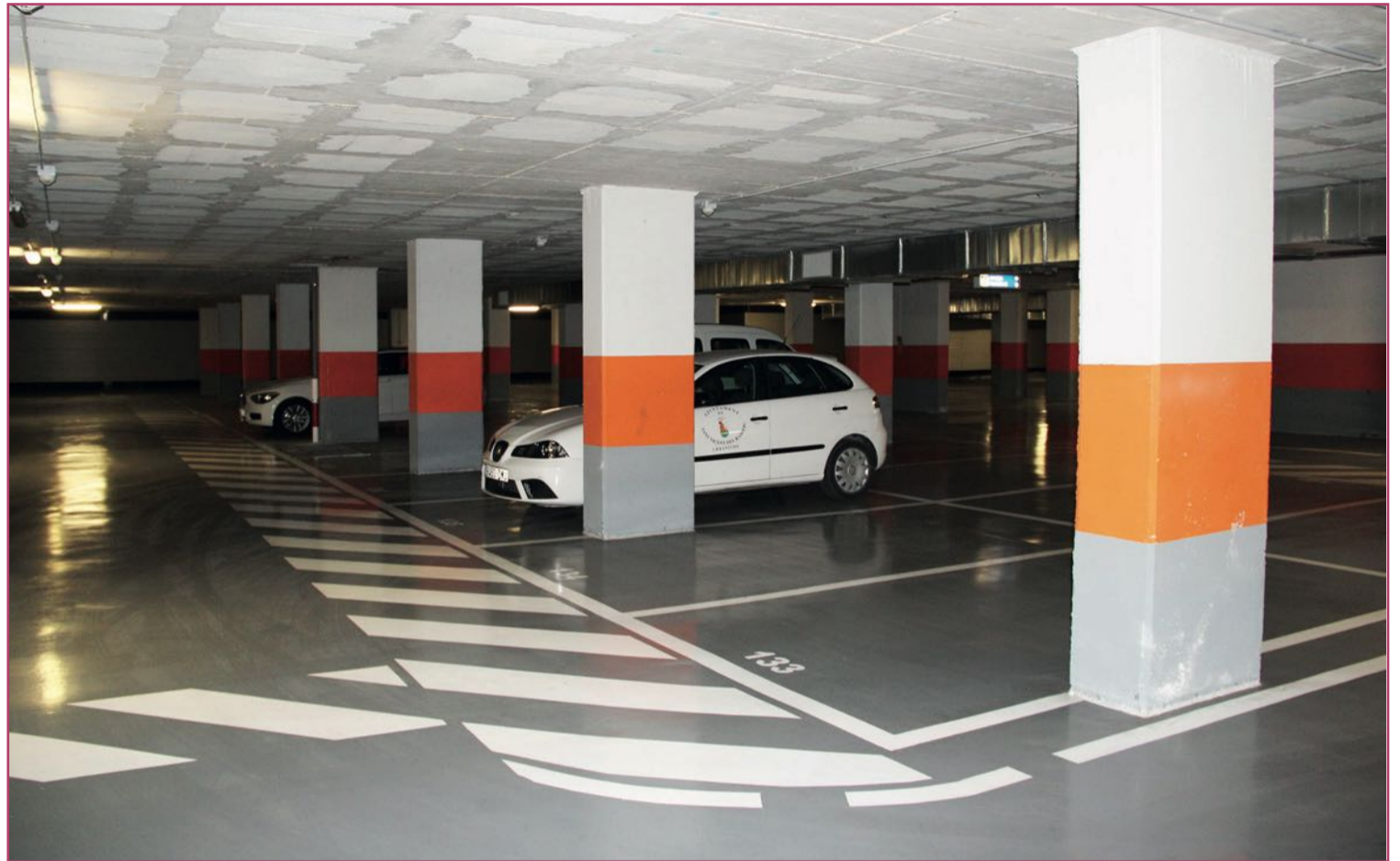
Parking subterráneo del Ayuntamiento.
