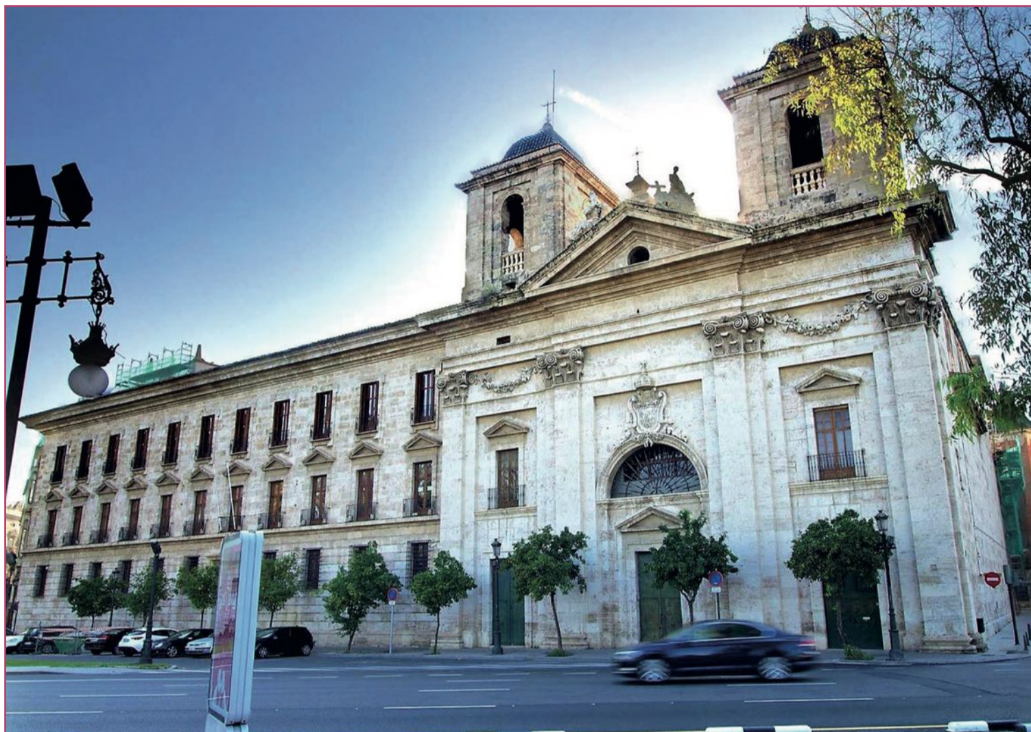
Fachada neoclásica de lo que fue iglesia y palacio del Temple en la ciudad.
