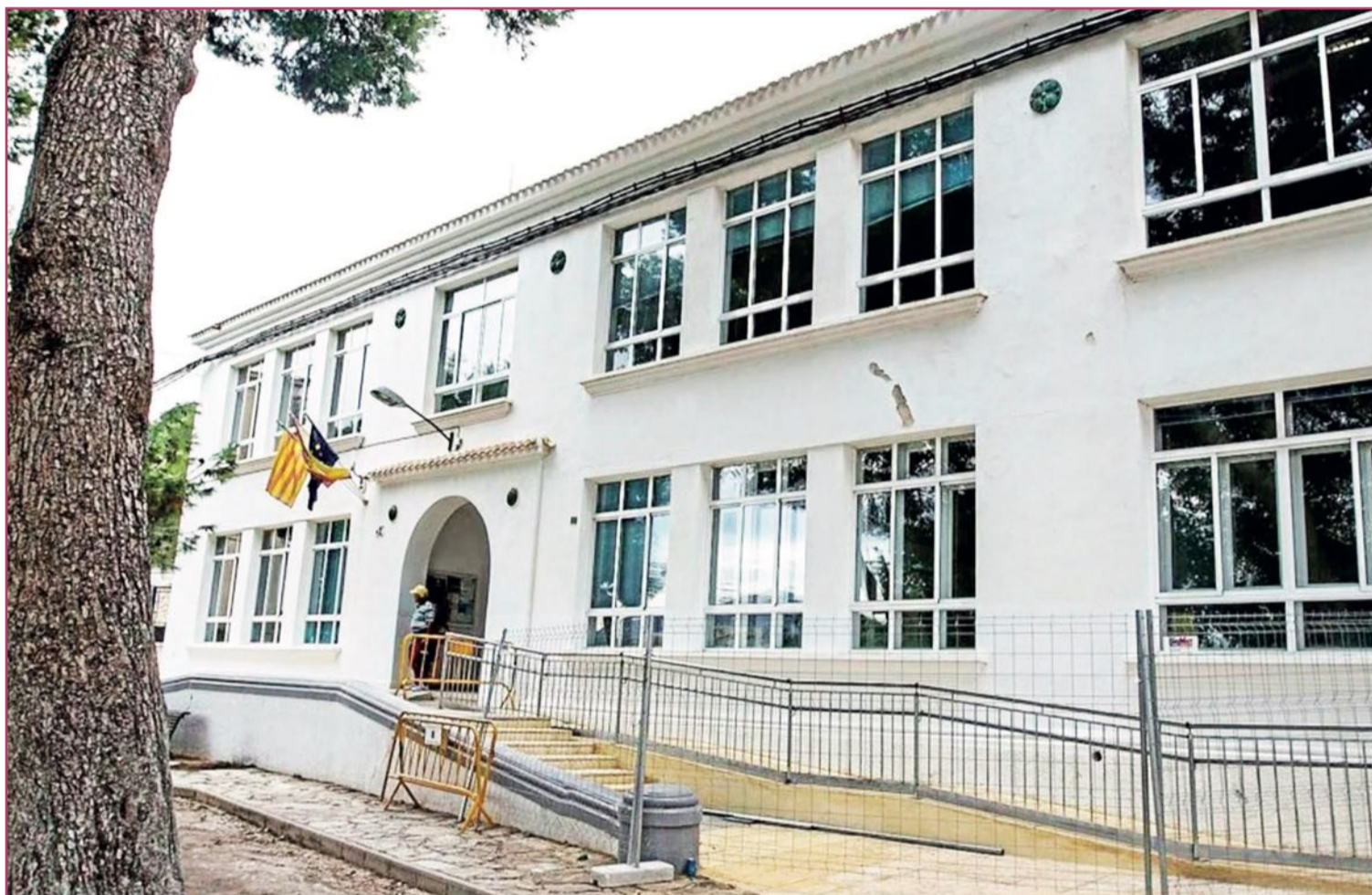
Imagen del conservatorio durante las obras de mejora.
