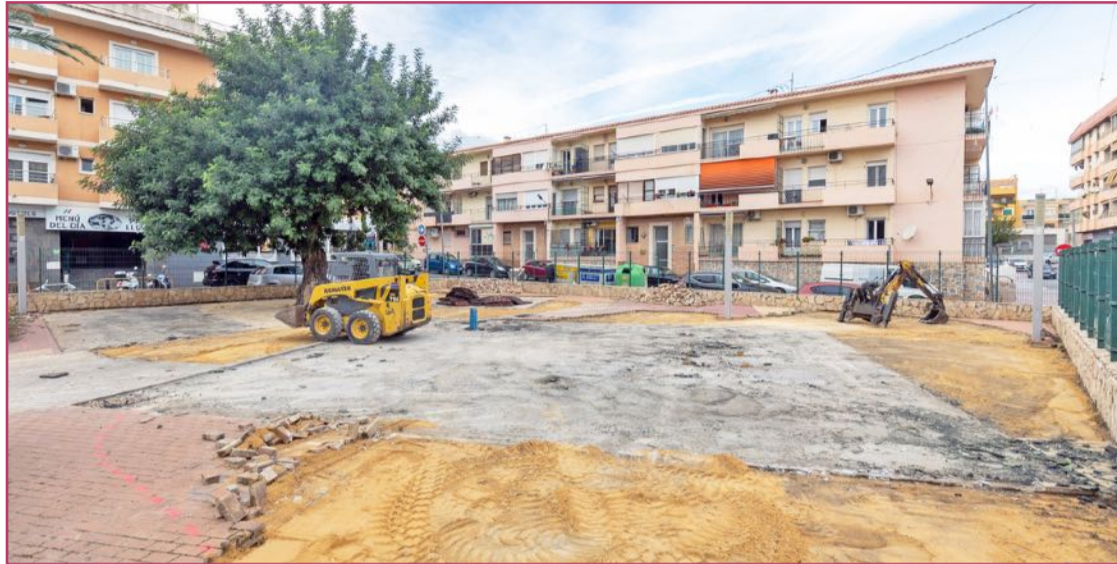
Las obras estarán finalizadas este mismo mes.
