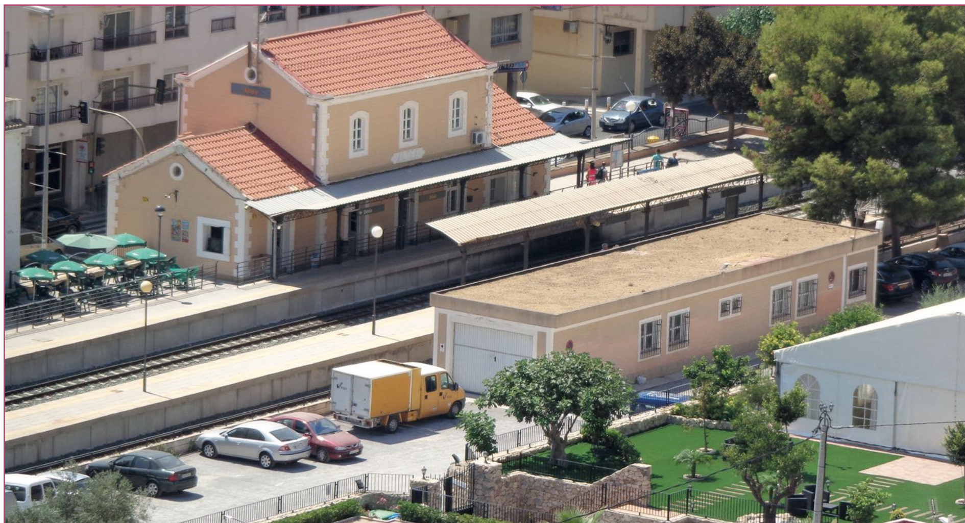
Estación de Altea.
