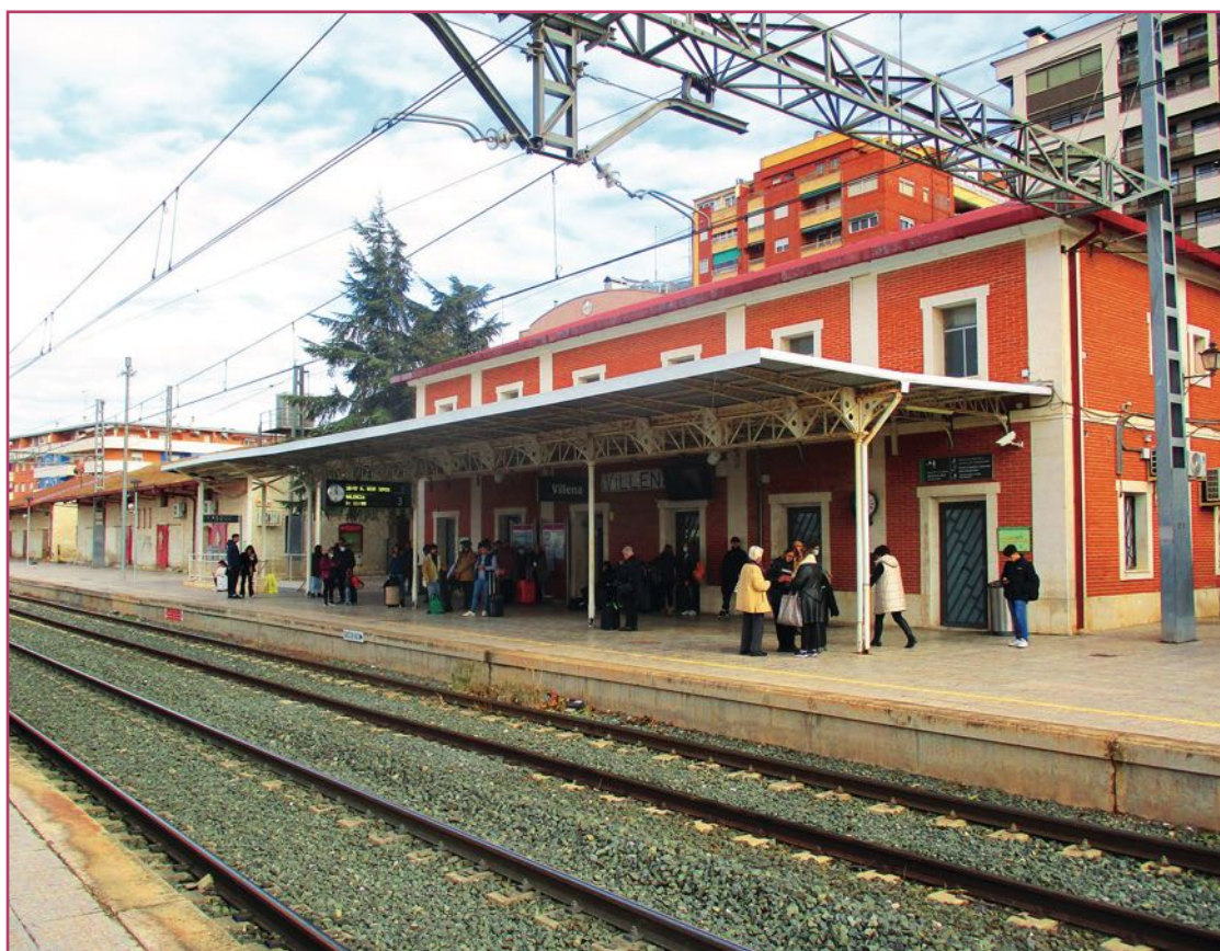
Estación de Villena.
