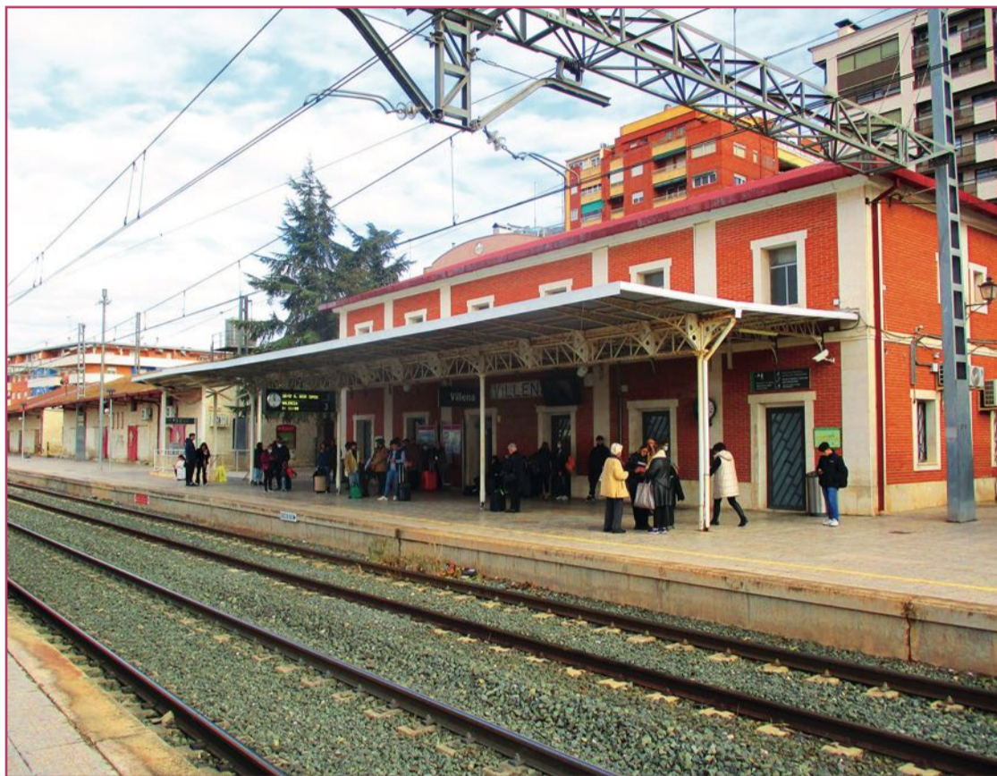
Estación de Villena.
