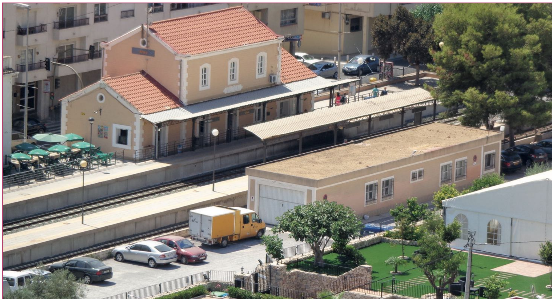
Estación de Altea.
