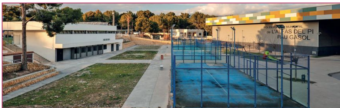
Estado actual de las pistas de pádel.
