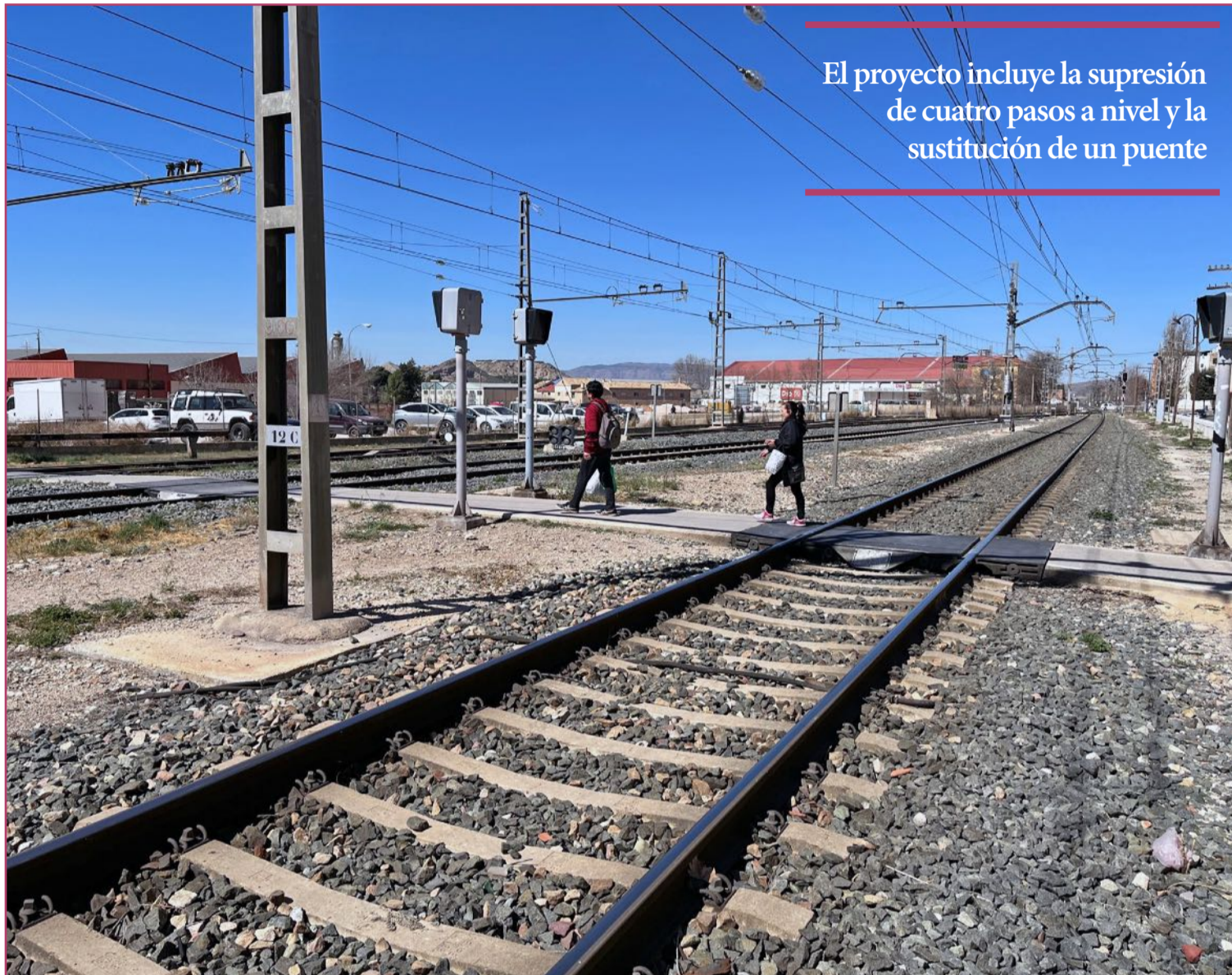
El paso a nivel de la calle Pintor Juan Gris será sustituido por un paso elevado y dos ascensores.
