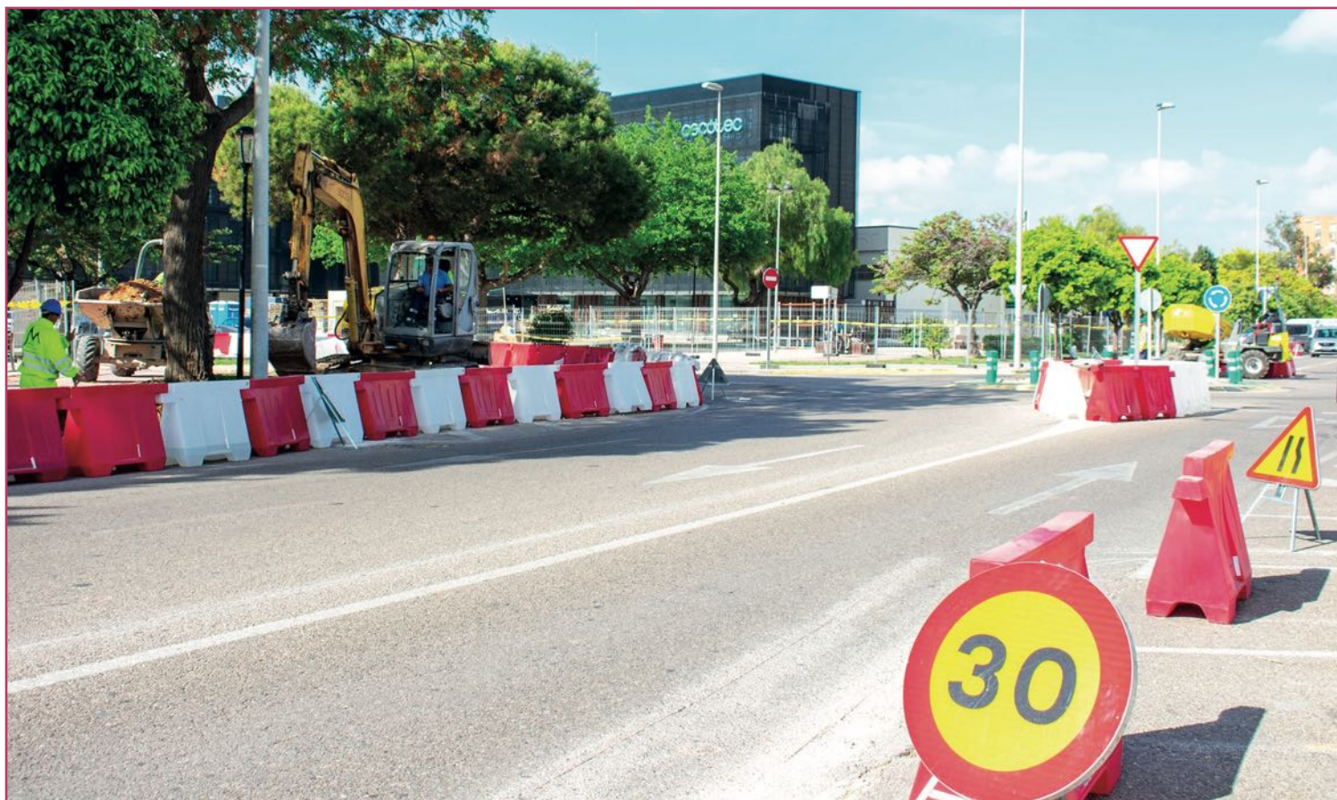
Obras junto a la sede de Cecotec.
