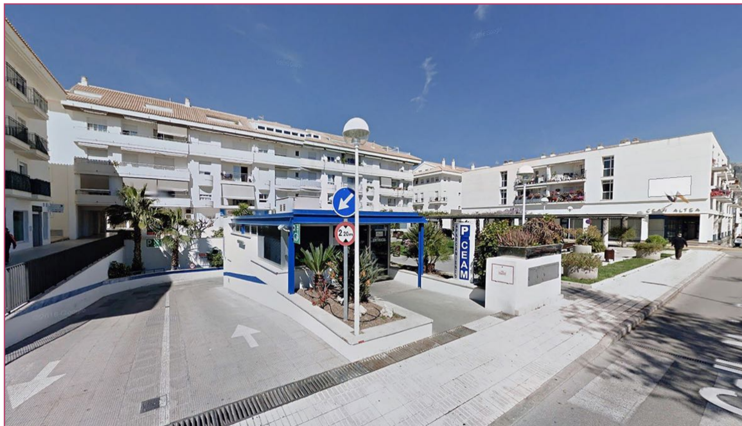
El parking del CEAM, el único que ha construido la concesionaria de los cinco previstos.
