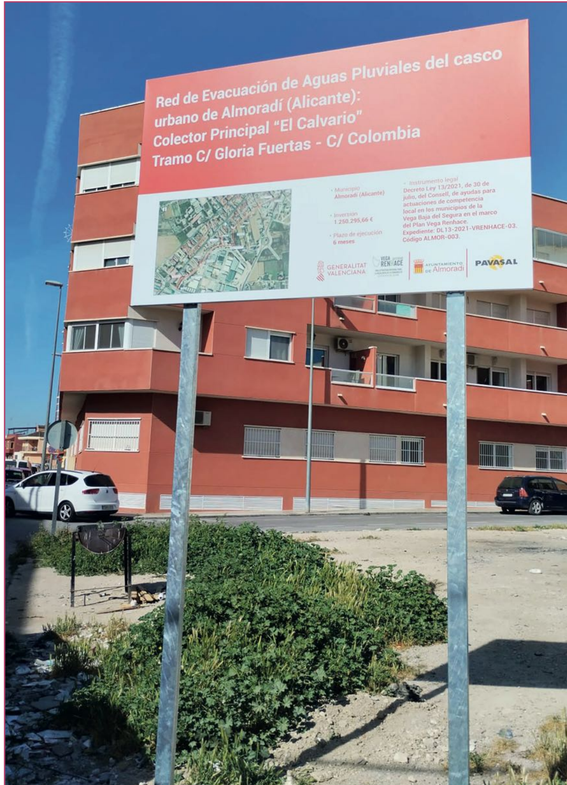
La prevención a los efectos de las gotas frías supone la realización de ingentes obras | Ayto. Almoradí
