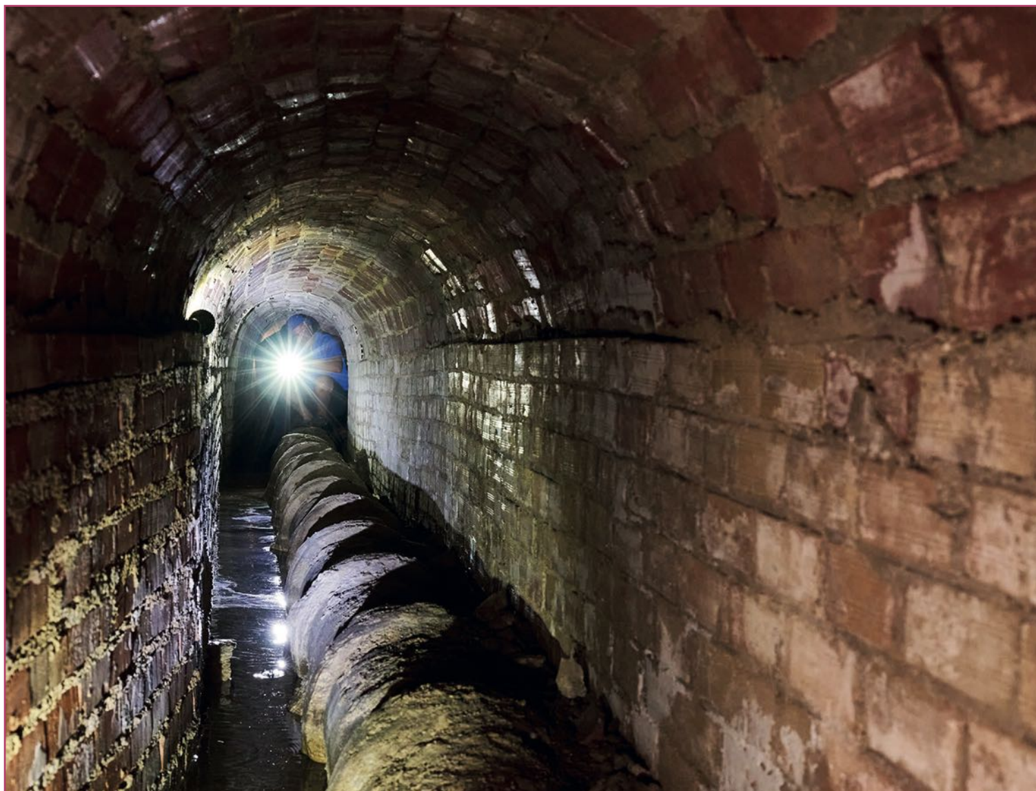
La galería se encuentra en un perfecto estado de conservación.
