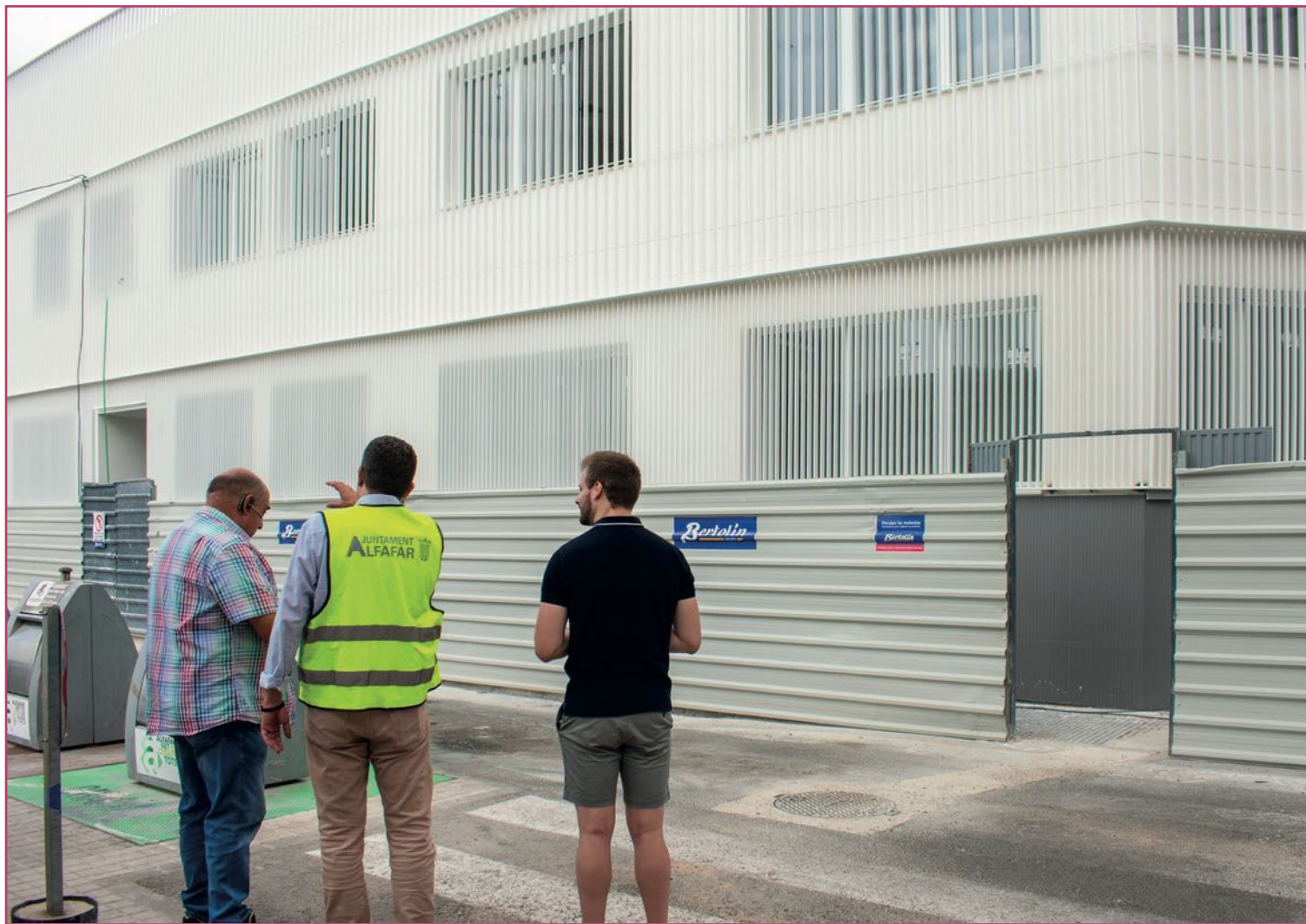
Estado actual del edificio Tauleta.
