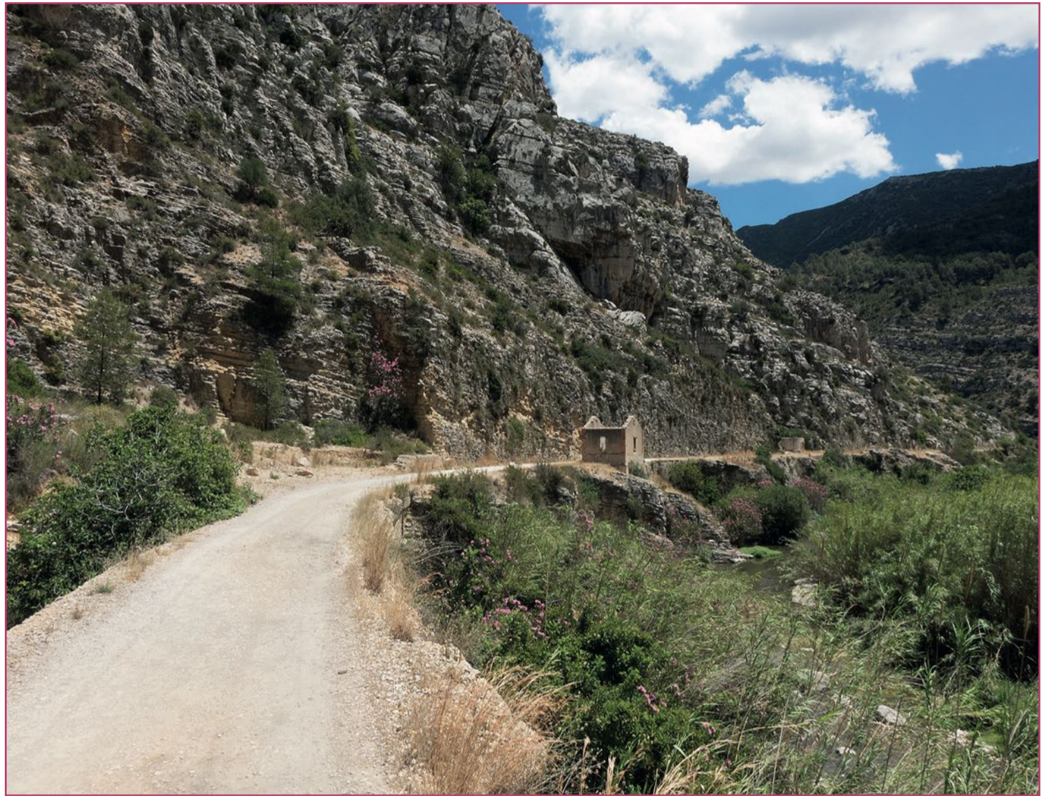
A su paso por el Barranc de l'Infern, la vía del Serpis aún conserva veteranas construcciones | RayRMC
