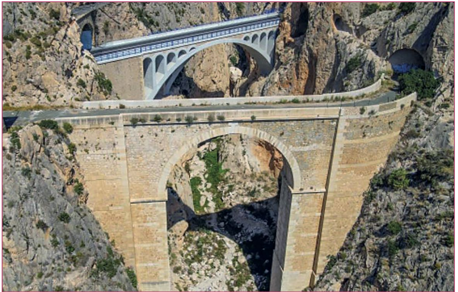
En primer plano se observa el primer túnel existente, ahora tapiado.
