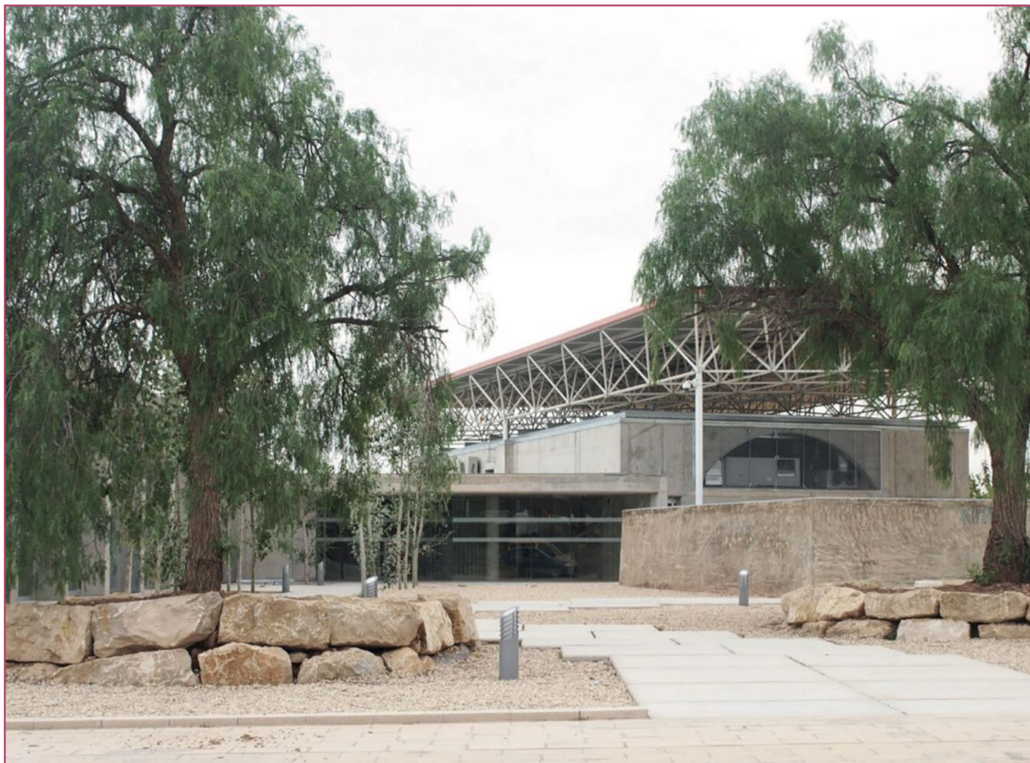
El Centro Polifuncional del polígono industrial El Canastell.
