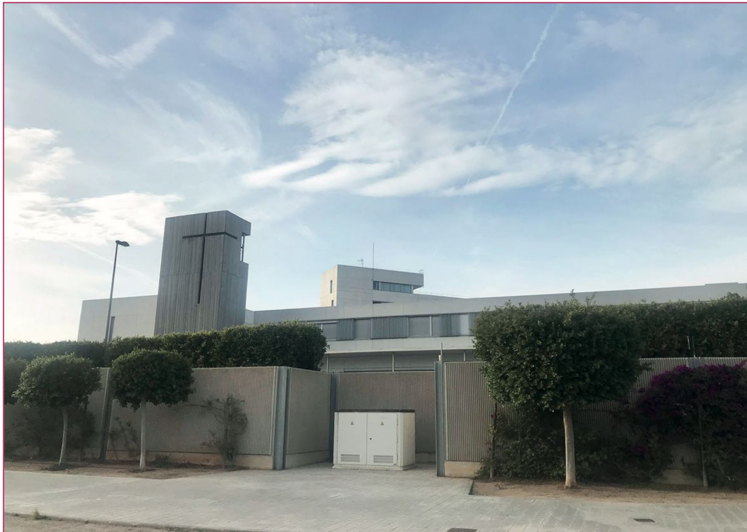
Vista exterior del monasterio de las dominicas.
