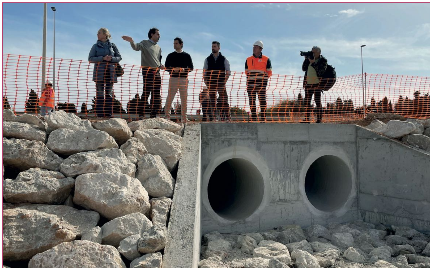
El alcalde, Eduardo Dolón, la concejala Sandra Sánchez y autoridades de AGAMED, supervisan las obras.
