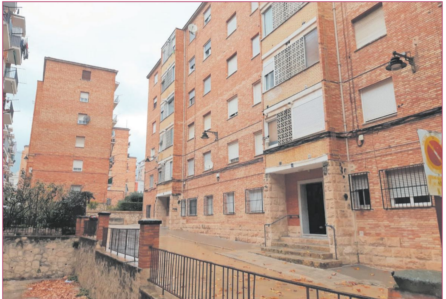
Viviendas a rehabilitar en Sagrado Corazón.
