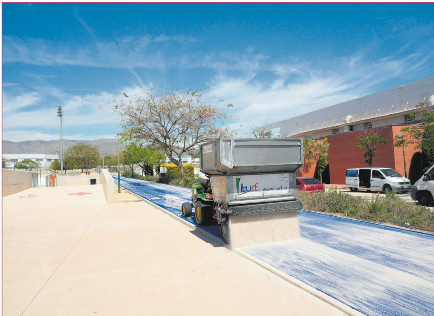
Trabajos en el anillo de running exterior al Pabellón Félix Candela.
