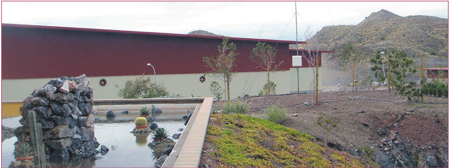
Planta de Piedra Negra
