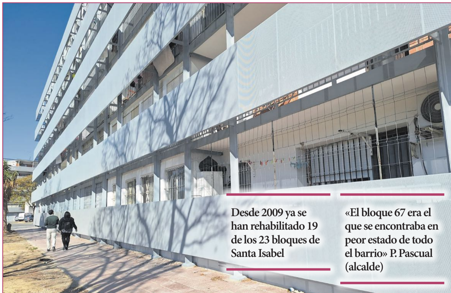
Bloque 67 tras las obras realizadas.
