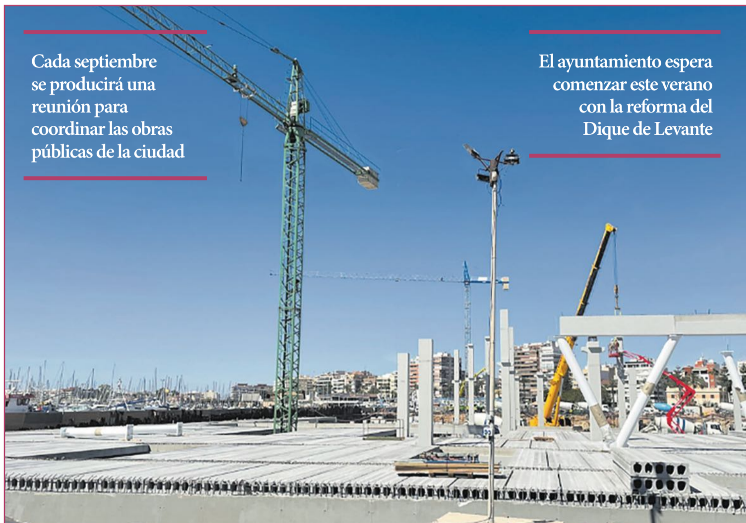
Obras en el Puerto.
