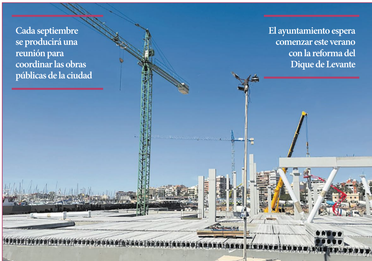
Obras en el Puerto.
