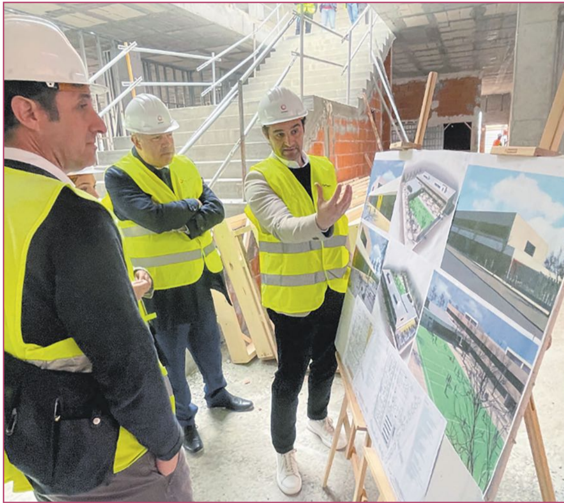
El alcalde, Eduardo Dolón, supervisando las obras del nuevo colegio Inmaculada.
