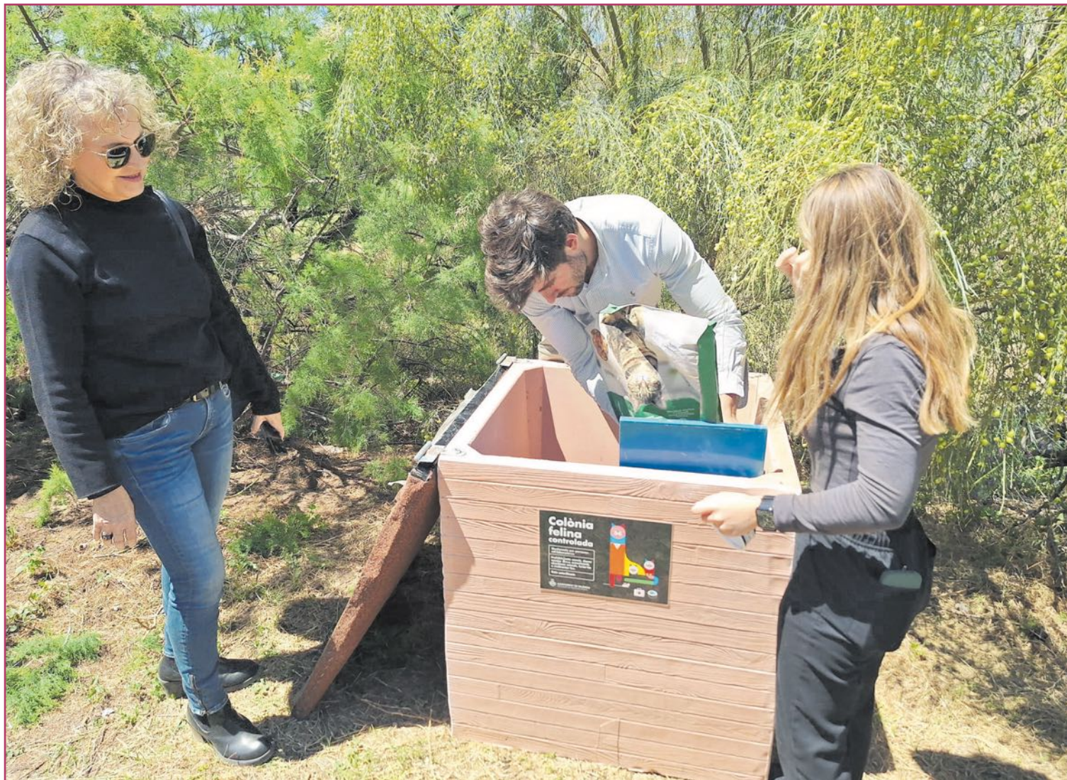
El concejal Juan Carlos Caballero colaborando en la instalación de una de las casetas.
