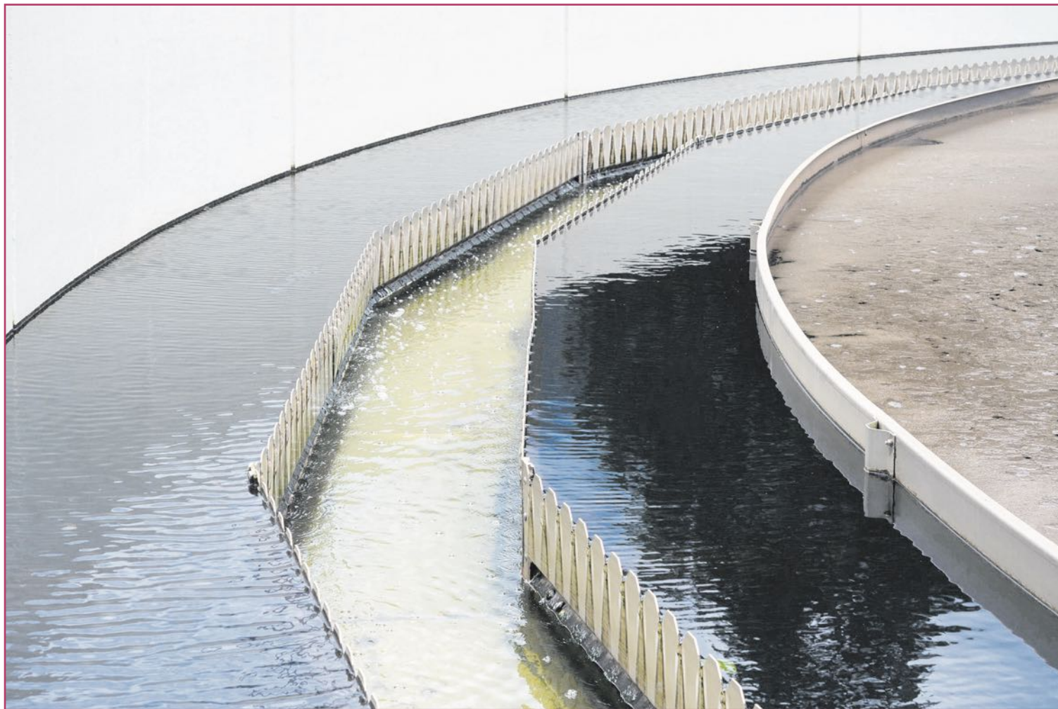
Convertir el 'agua bruta', la ya usada o la salobre en agua potable es uno de los retos de estas plantas.
