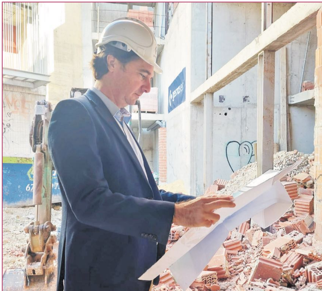
El concejal de Juan supervisa la construcción de viviendas públicas del Portón.
